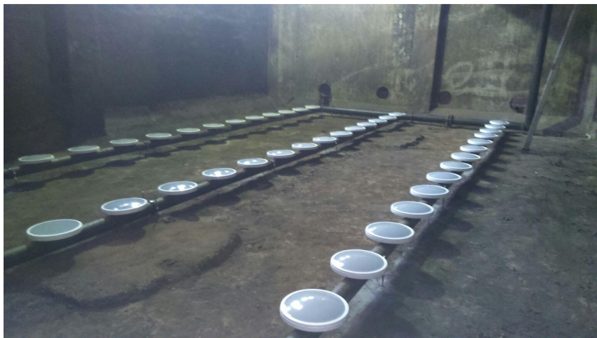
Рисунок 2.7 – Мелкопузырчатая аэрационная система А350
