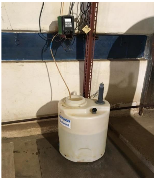
Рисунок 2.6 – Установка дозирования препарата Пуралат-Бингсти
