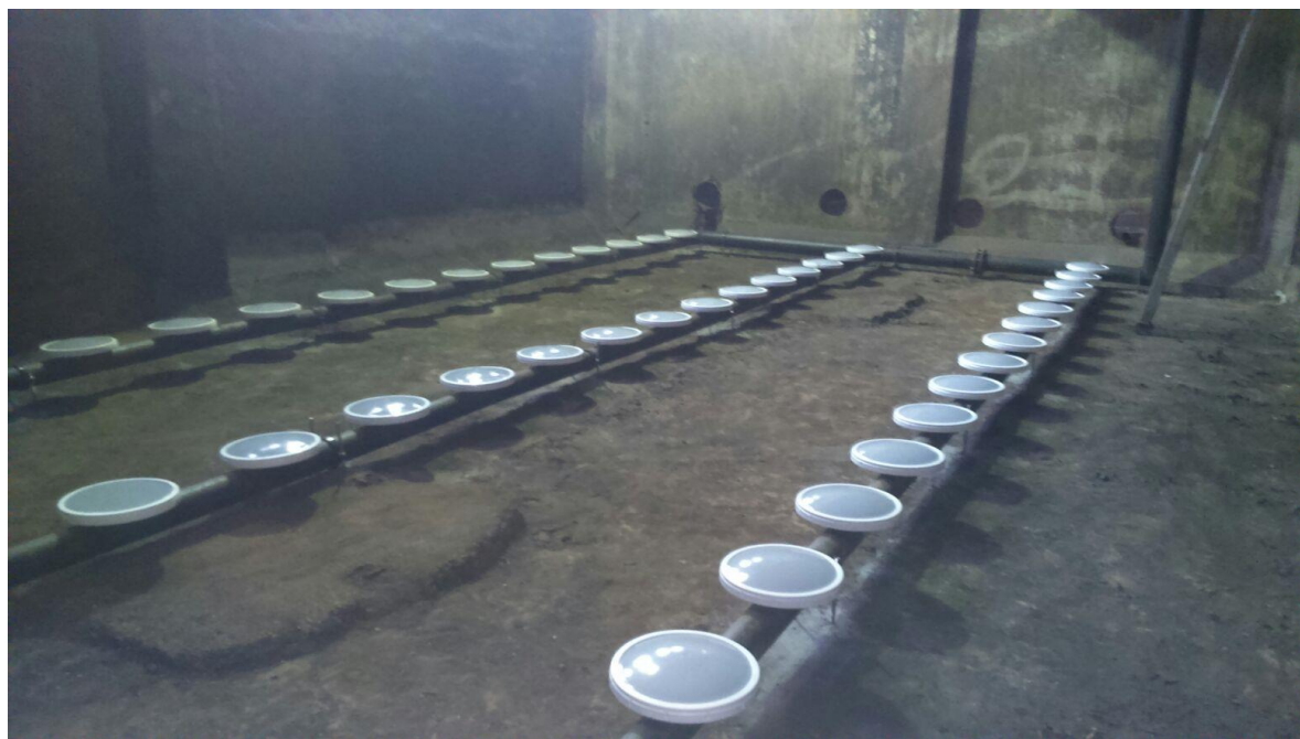
Рисунок 2.7 – Мелкопузырчатая аэрационная система А350
