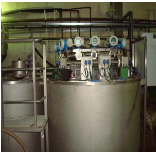
Рисунок 20. Установка приготовления и подачи флокулянта в автоматической системе
