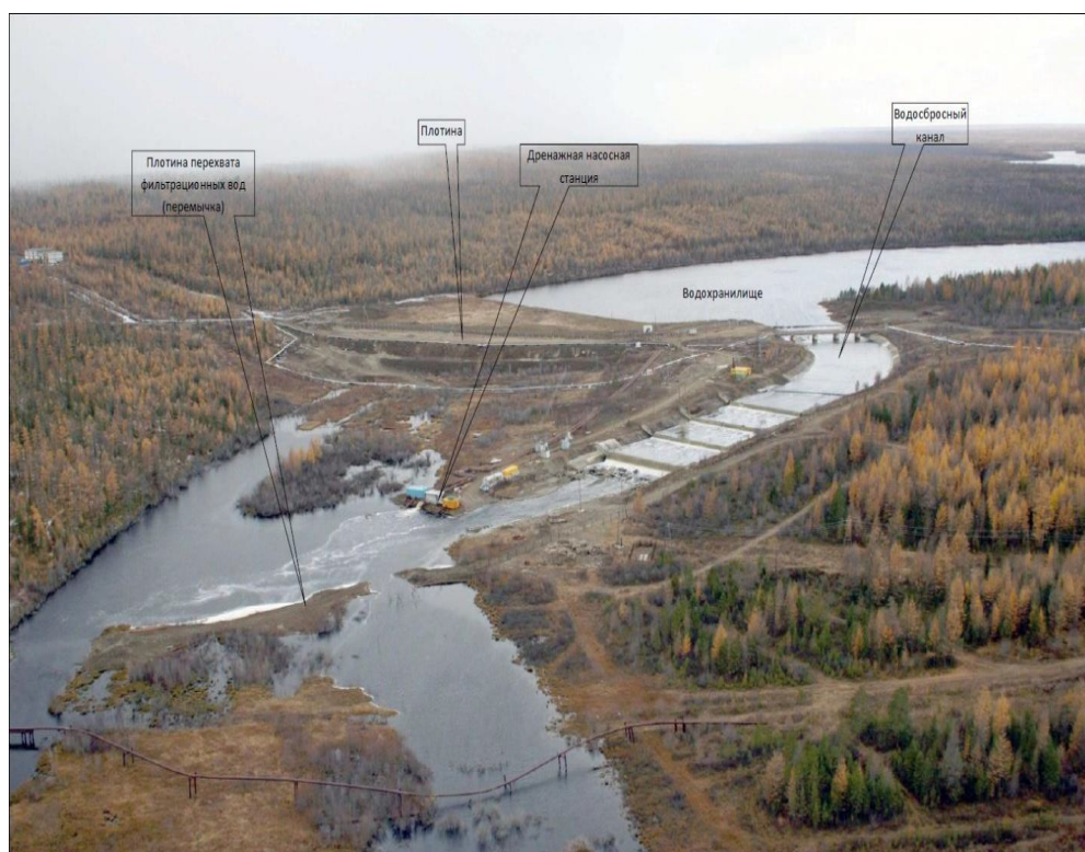
Рисунок 6. Вид на ГТС гидроузла с нижнего бьефа
