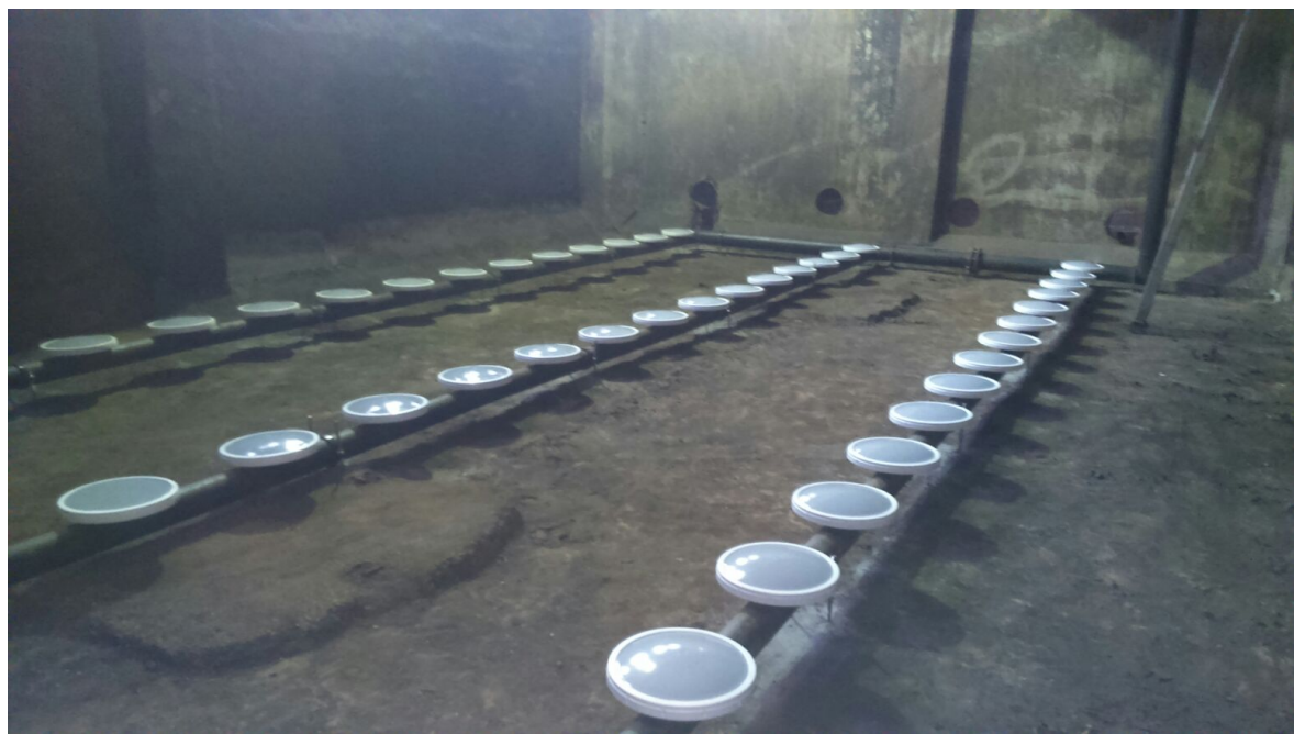
Рисунок 19. Мелкопузырчатая аэрационная система А350
